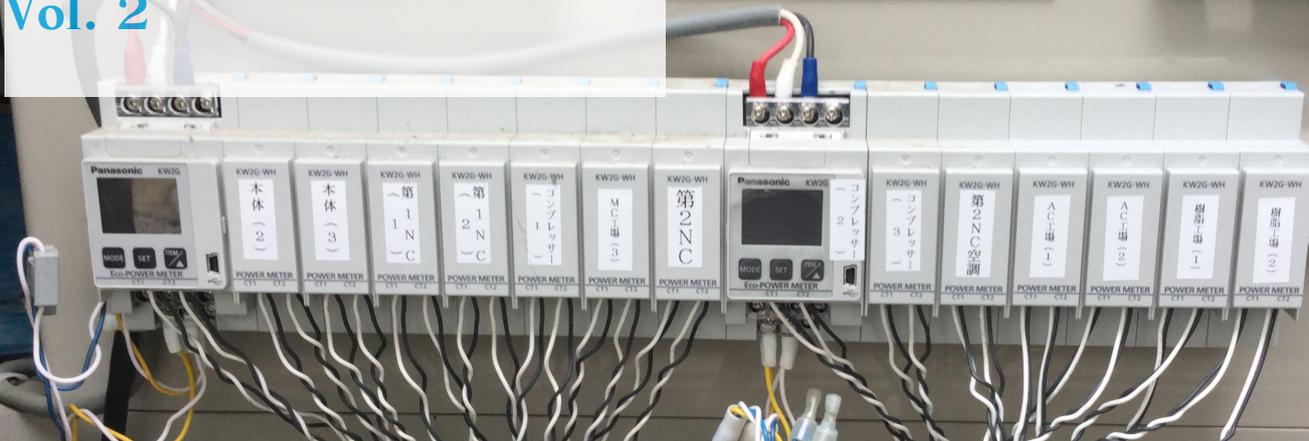
技術課では約10年前からデマンド監視と併せて電力監視機器の販売・設定・調整・拡張・IoT化等に取り組んでいます。最近の動向として、回転式電力量計の製造中止に伴う電子式への更新、または並行設置等の要望が増えています。技術課では単に電力監視を立ち上げるだけではなく、お客様が必要としている電力情報（電圧・電流・力率等）を個別に計測・表示するソフトウェアや水やガスの計測・表示・帳票出力、サインージ作成を承ります。
